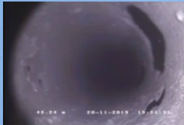
Rotture delle tubazioni
